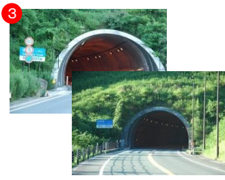
③ 俄山トンネルと南阿蘇トンネル、2つのトンネルを抜けて南阿蘇へ入る。
